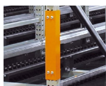
支柱ガード フォークリフトとの接触から支柱を保護するためのものです。
