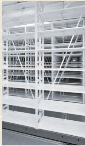
背面ブレースによる補強
